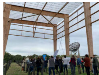
Site d'exclusion des eaux de pluie lors de l'inauguration
